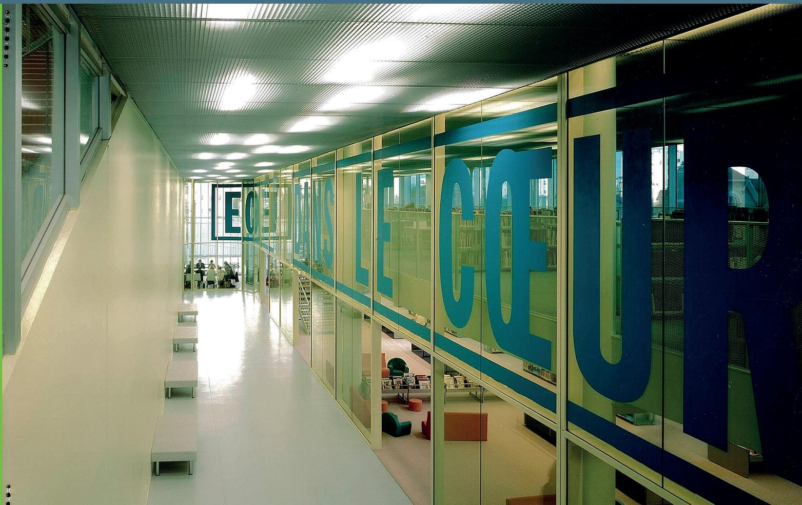
Plafond cellulaire composé d'un quadrillage de lamelles formant des mailles carrées de différents modules et pouvant être réalisés de différentes hauteurs.
